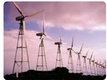
Parque eólico: utiliza la energía cinética del viento para mover las aspas de los aerogeneradores, los que producen energía eléctrica.
