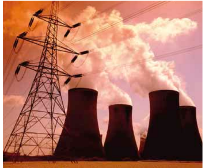
▲ Chimeneas de una central nuclear
